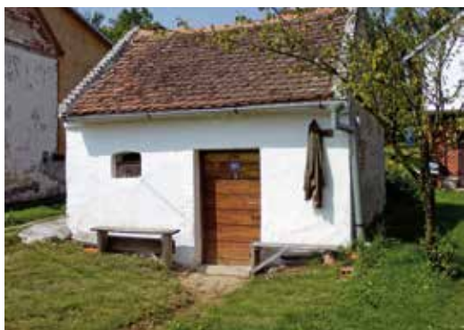
Dubňany, původní sklep
