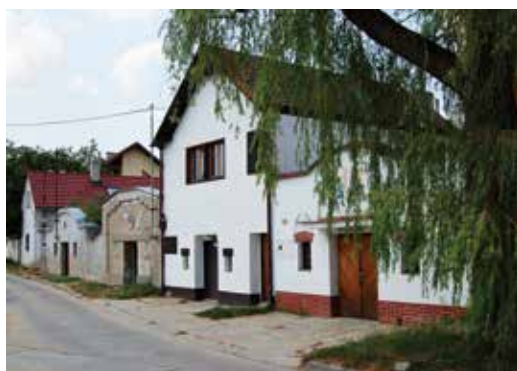
Bzenec, nevhodné úpravy v řadě původních sklepů
