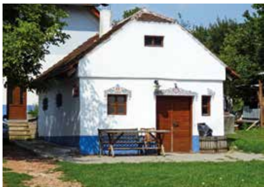
Dubňany, přestavba se zachováním hmoty a architektonických prvků
